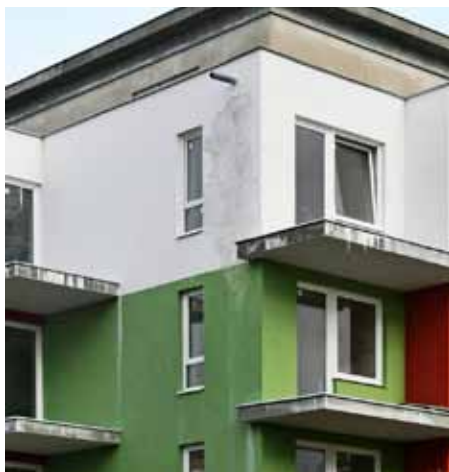
Finální povrchové úpravy z tenkovrstvých omítek včetně jejich typických vad a poruch
