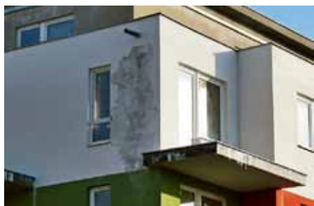
Finální povrchové úpravy z tenkovrstvých omítek včetně jejich typických vad a poruch
