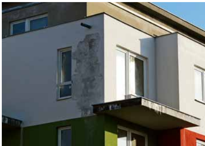
Finální povrchové úpravy z tenkovrstvých omítek včetně jejich typických vad a poruch
