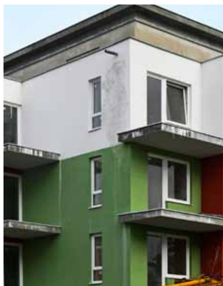
Finální povrchové úpravy z tenkovrstvých omítek včetně jejich typických vad a poruch
