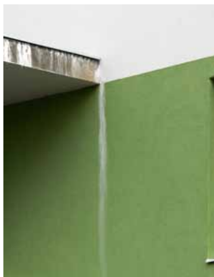
Finální povrchové úpravy z tenkovrstvých omítek včetně jejich typických vad a poruch
